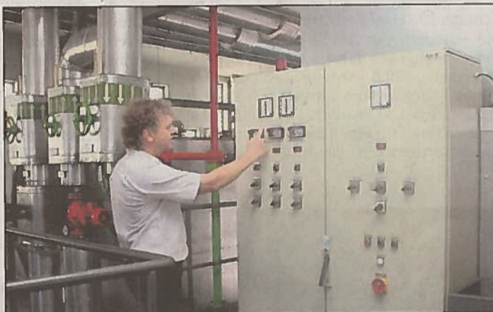
Kontrolle: Jochen Hupfeld, technischer Leiter des Krematoriums, regelt die Temperatur in den Brennkammern.
